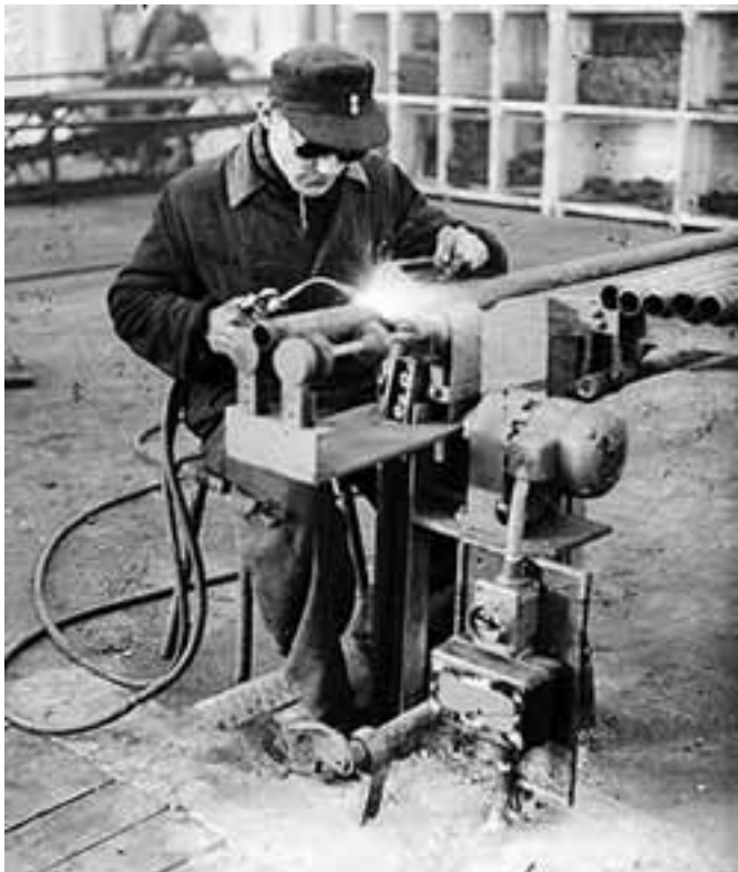
Abb. 5: 1948 – Drehvorrichtung Rohrschweisser Quelle: Virtuelles Museum des DVS
