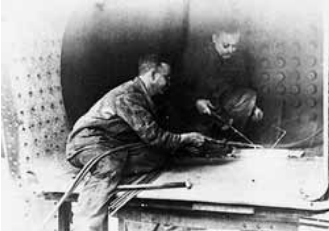
Abb. 4: 1934 – Gasschweisser bei der Arbeit
