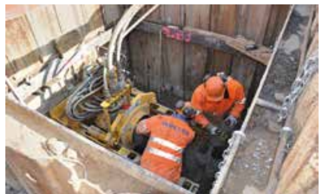
Abb. 4 & 5: Bohrpressarbeiten unter Trasse
