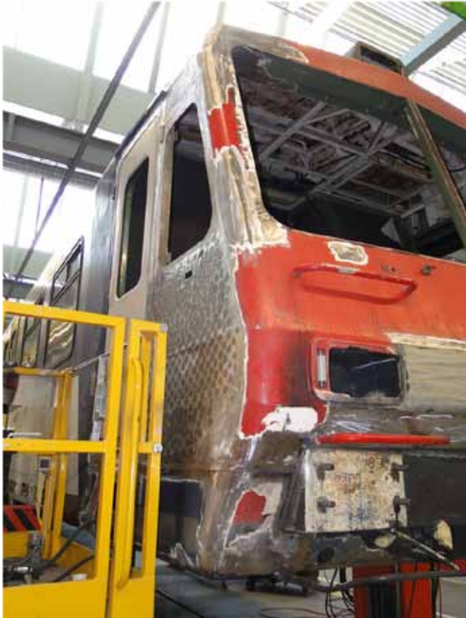
Reparaturarbeiten an Zugskomposition
